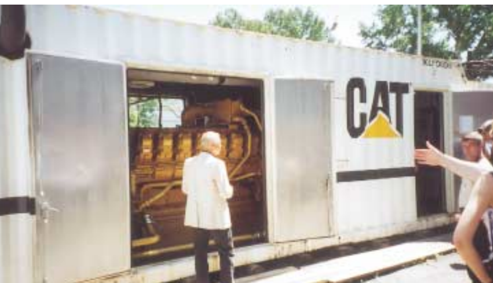
Foto 1 : CAT verbrandingsmotor voor het opwekken van elektriciteit uit CH 4 , afkomstig van een koolmijn in de Kusbas regio van Siberië.
